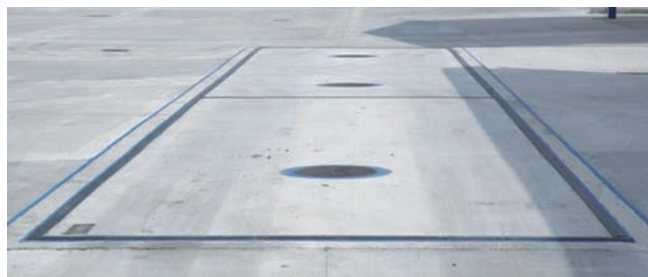
Obr. 44 Zapustená cestná mostová váha
