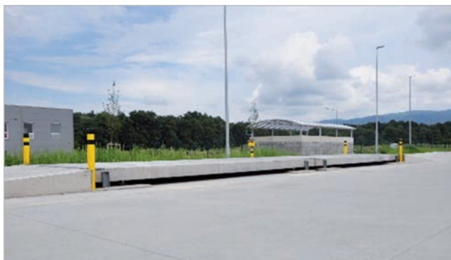
Obr. 46 Prefabrikovaná nadúrovňová cestná mostová váha s betónovými nájazdmi
