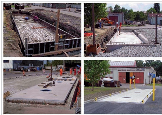
Obr. 43 Monolitický základ
