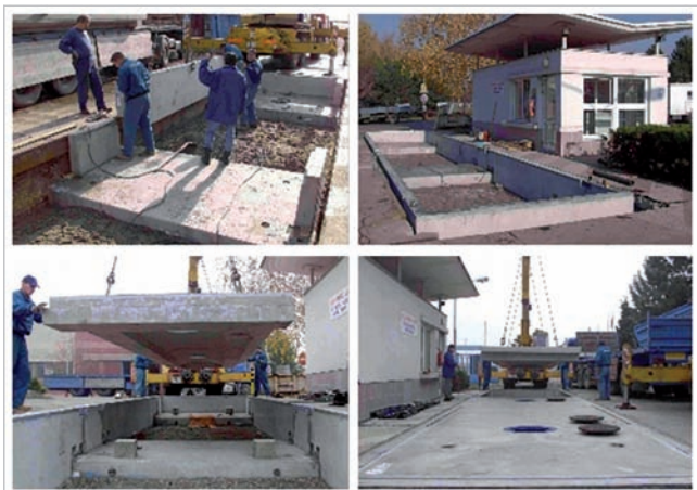
Obr. 42 Prefabrikovaný základ
